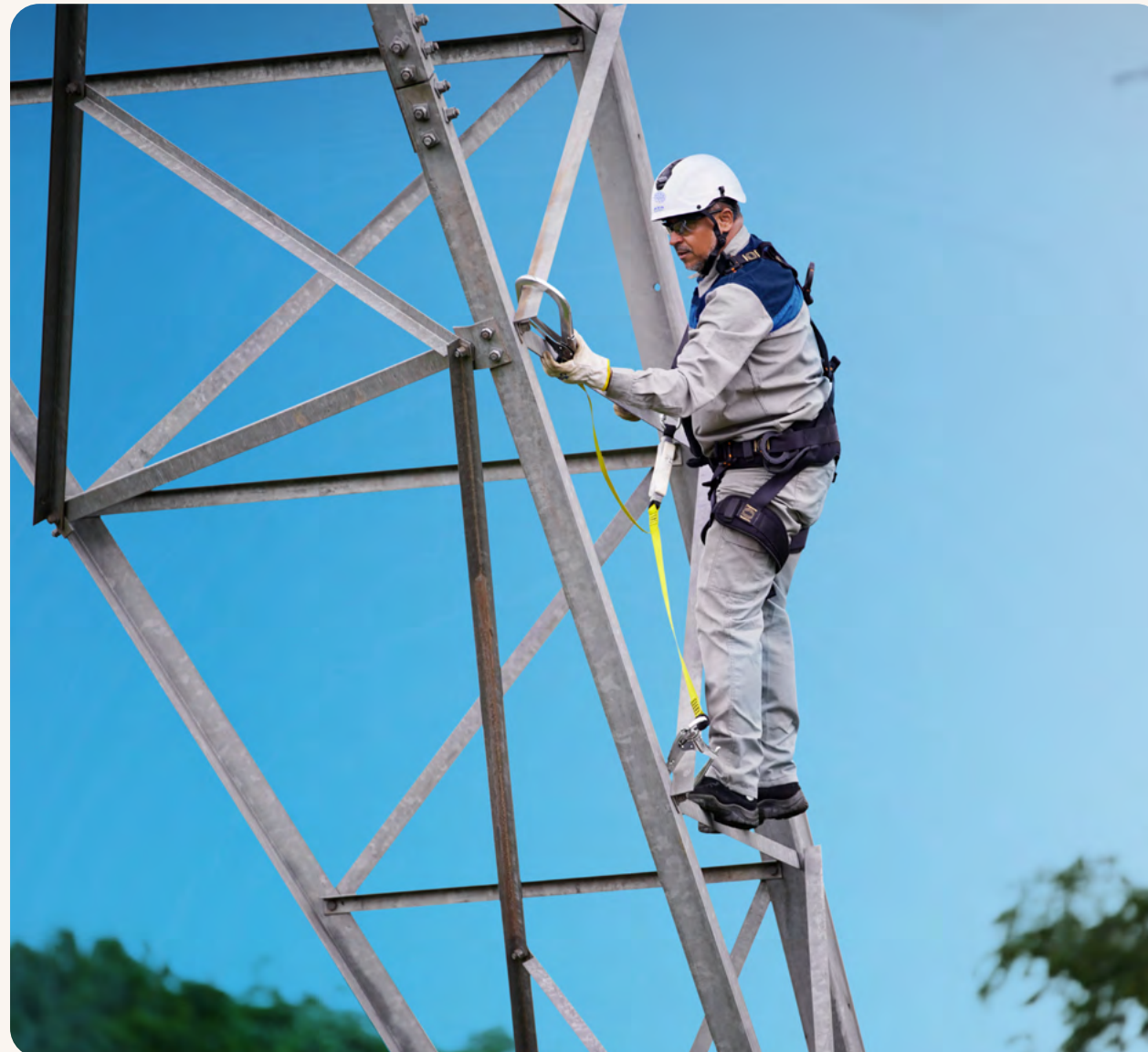
Manutenção em linha de transmissão – Acervo AXIA
