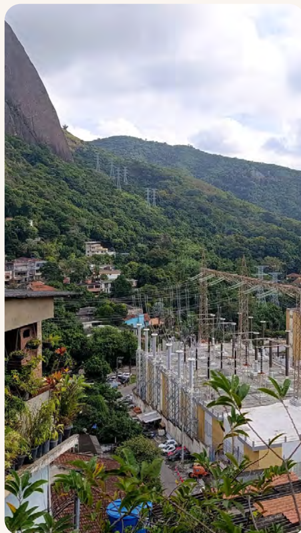
Modernização da Subestação Grajaú - Acervo AXIA
