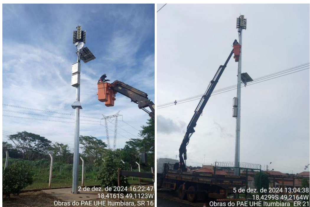
Figura 10 – Manutenção das Estações Remotas implantadas.
